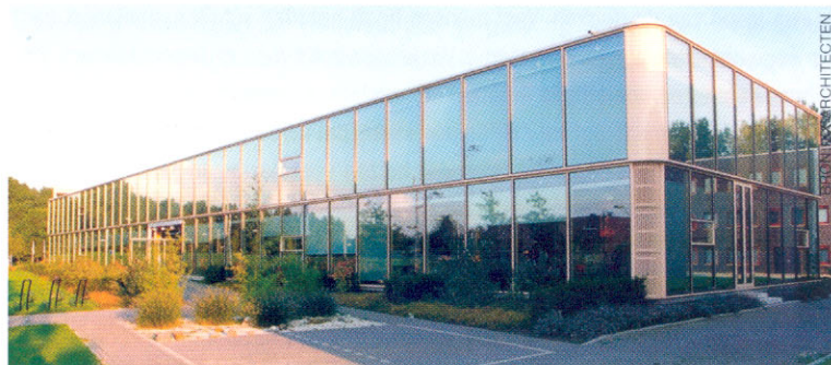
Het XX-gebouw in Delft is zo gematerialiseerd dat de levensduur van het gebouw even lang is als de gebruiksduur ervan: twintig jaar. Het gebouw bestaat uit hout, glas, zand en karton.
